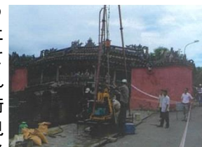
地盤のボーリング調査
