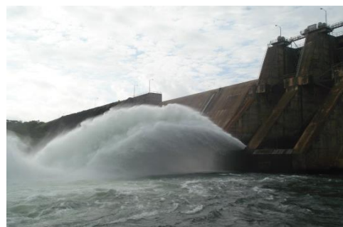
イグアスダム
