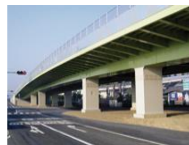
図6 急速施工型立体交差橋
