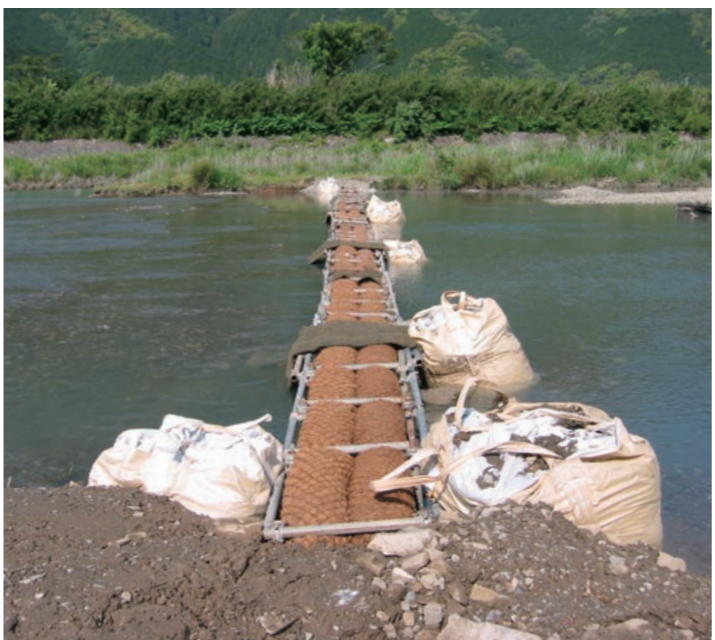
[右] サモアの首都アピア近郊の河川。土壌侵食によって水が赤く染まっており、これが沿岸域に流出して景観や水質の悪化を引き起こしている [左] 沖縄県以外にも国内各地の河川で濁水対策として設置されているバイオログフィルター（写真は三重県の船津川）
