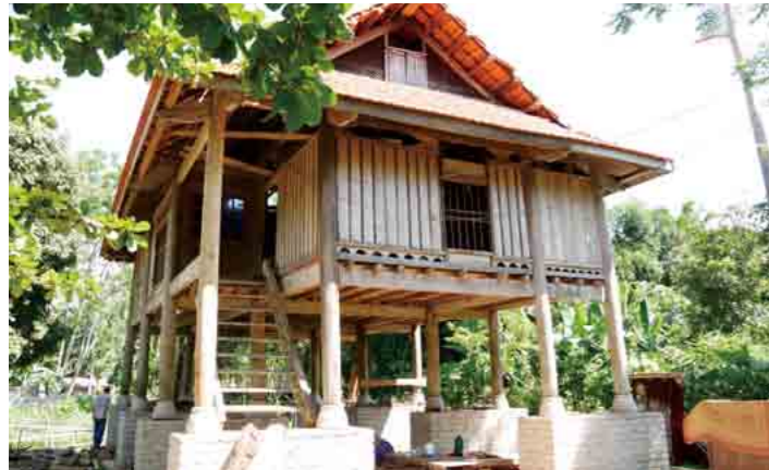
ヌア村の住民が新たに建設しているホームステイ用の高床式住居。1階は倉庫や家畜小屋で、2階が住居となる。木材を使った伝統的な建築方法を用いる
