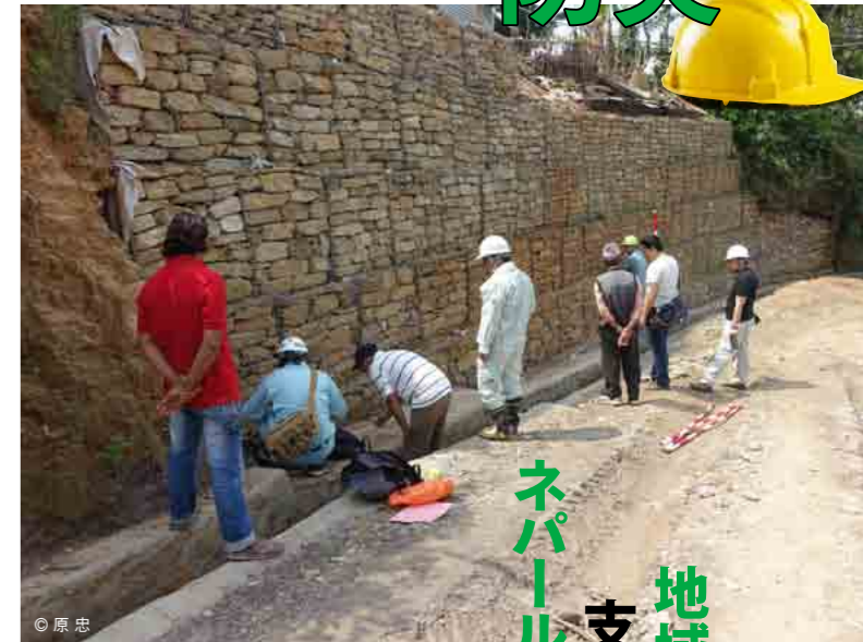
現地で行った蛇籠の施工の比較検証。1回目のネパール式(写真右)に対して、3回目はネパール人と日本人が共同作業を行い、山の斜面を利用して蛇籠を階段積みにした(写真左)。こちらのほうが蛇籠が崩れにくく土砂災害に対して強くなる
