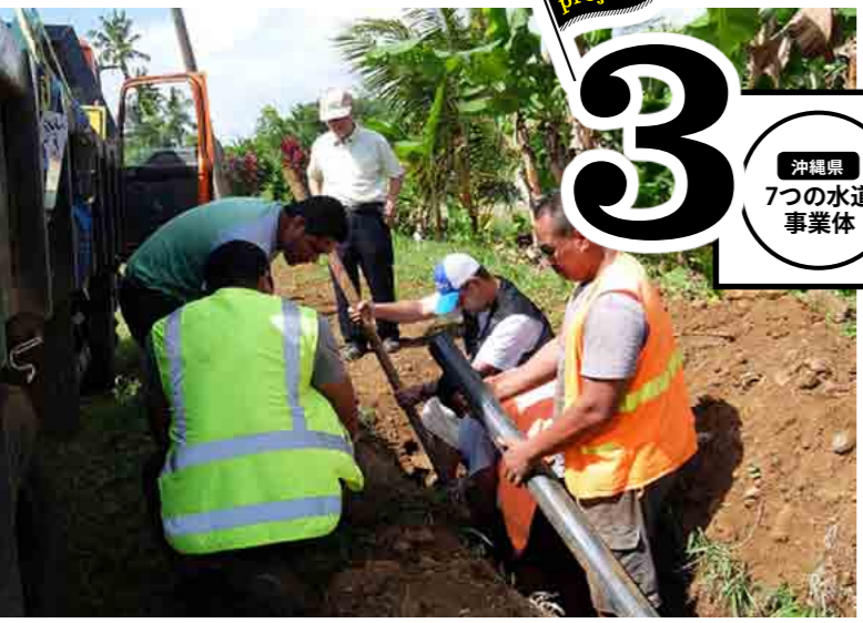
漏水箇所をつきとめて水道管を交換する
