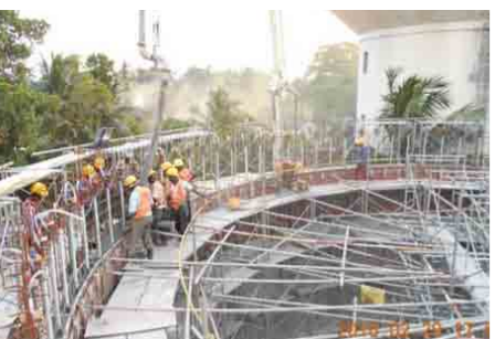
上:タンクの屋根はエアドーム工法を採用。工期が短縮でき、作業の安全も確保できる方法だ。このドームの上にコンクリートを打って屋根とする／下:プレストレストコンクリートでタンクの側壁を造る作業中。現場のすぐそばにヤシの木が見える
