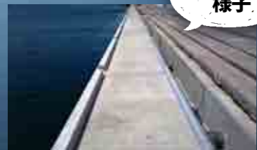
復旧された3B岸壁。5月には最新の防舷材や係船柱が設置されて船が安全に接岸できるようになった。
