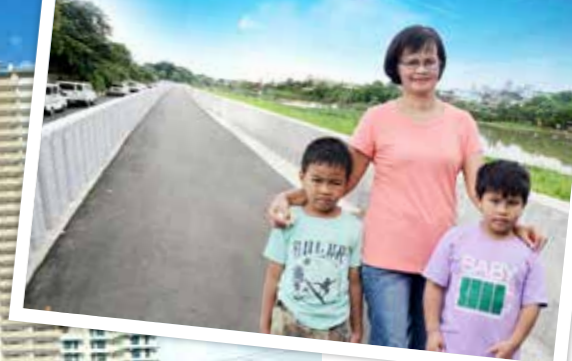
パッシング・マリキナ川河川改修工事で整備された堤防(左)と周辺の住民(上)。
