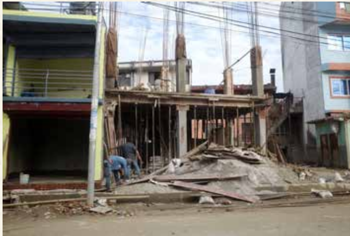
2019年に撮影した、カトマンズ盆地の工事現場の様子。
