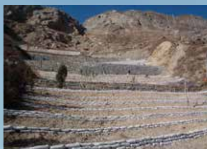
写真 11 四川省森林造成施工中
