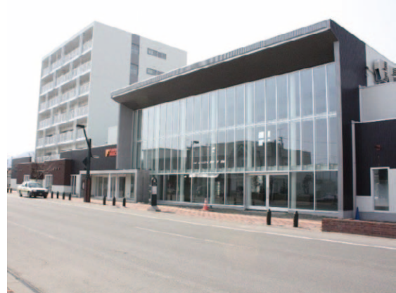
フラノマルシェ 2 ネーブルタウン
