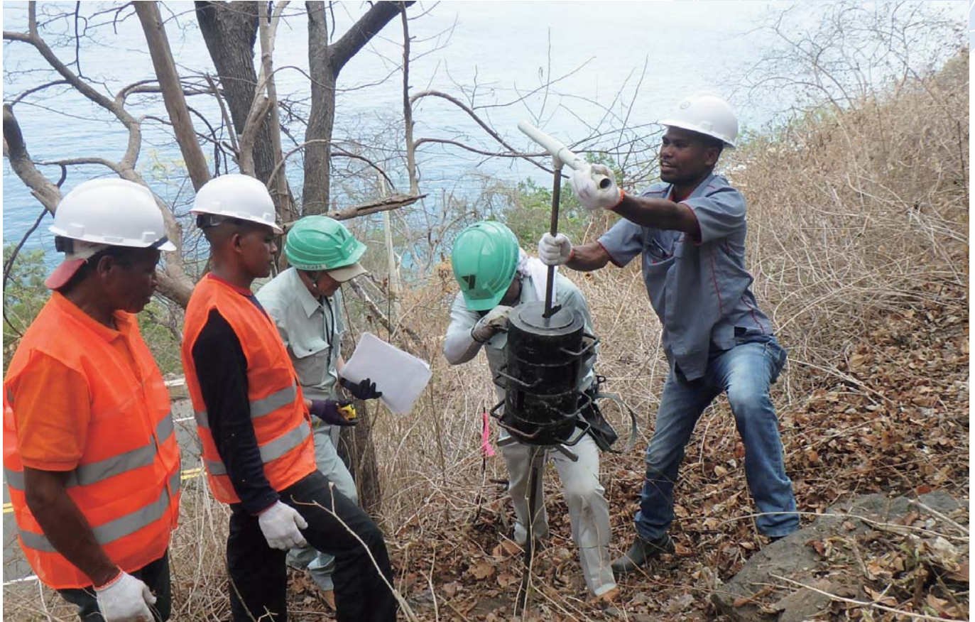
国道3号線の斜面の地質、強度調査
