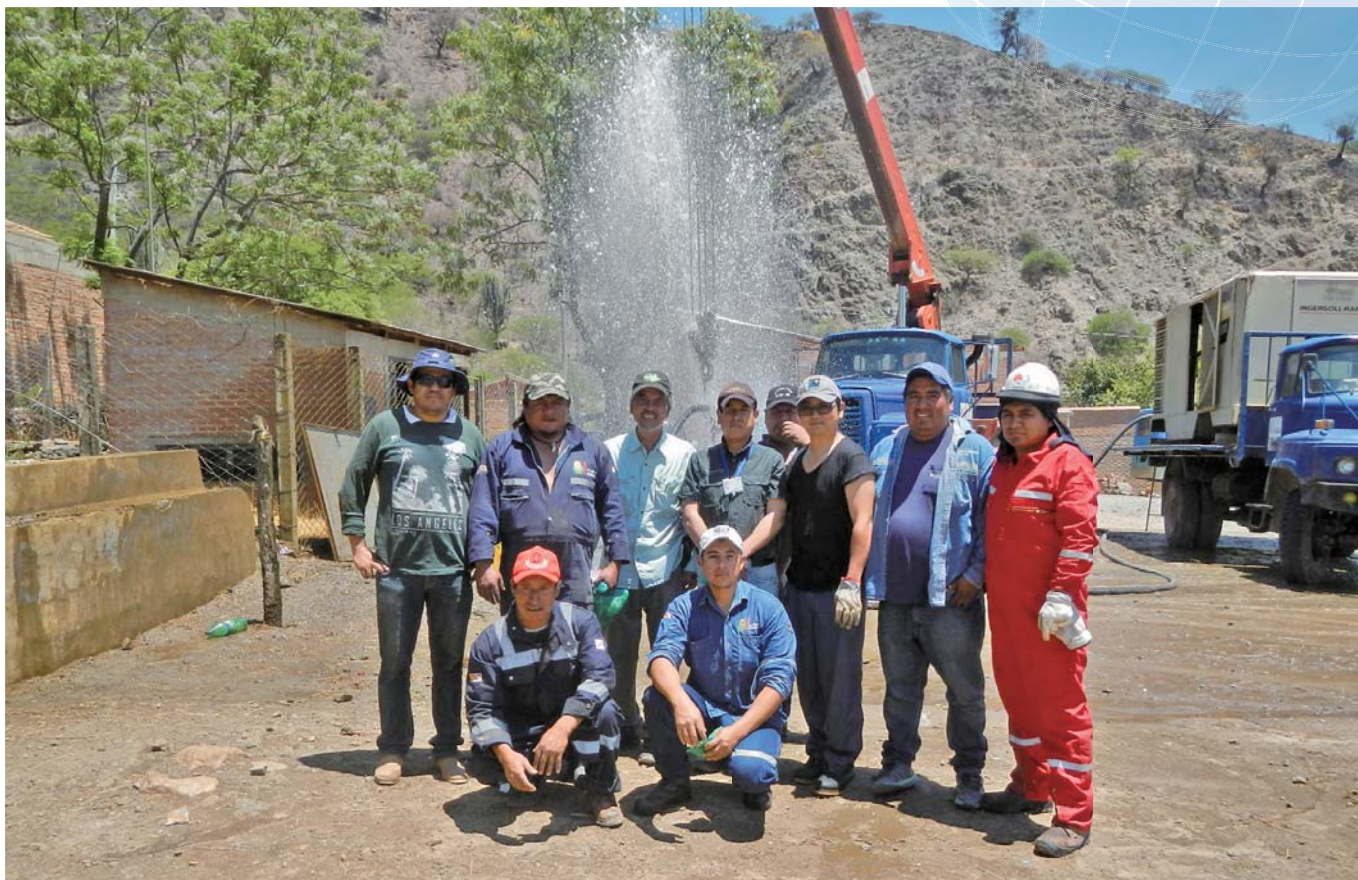
井戸カメラによる診断・改修後の井戸
