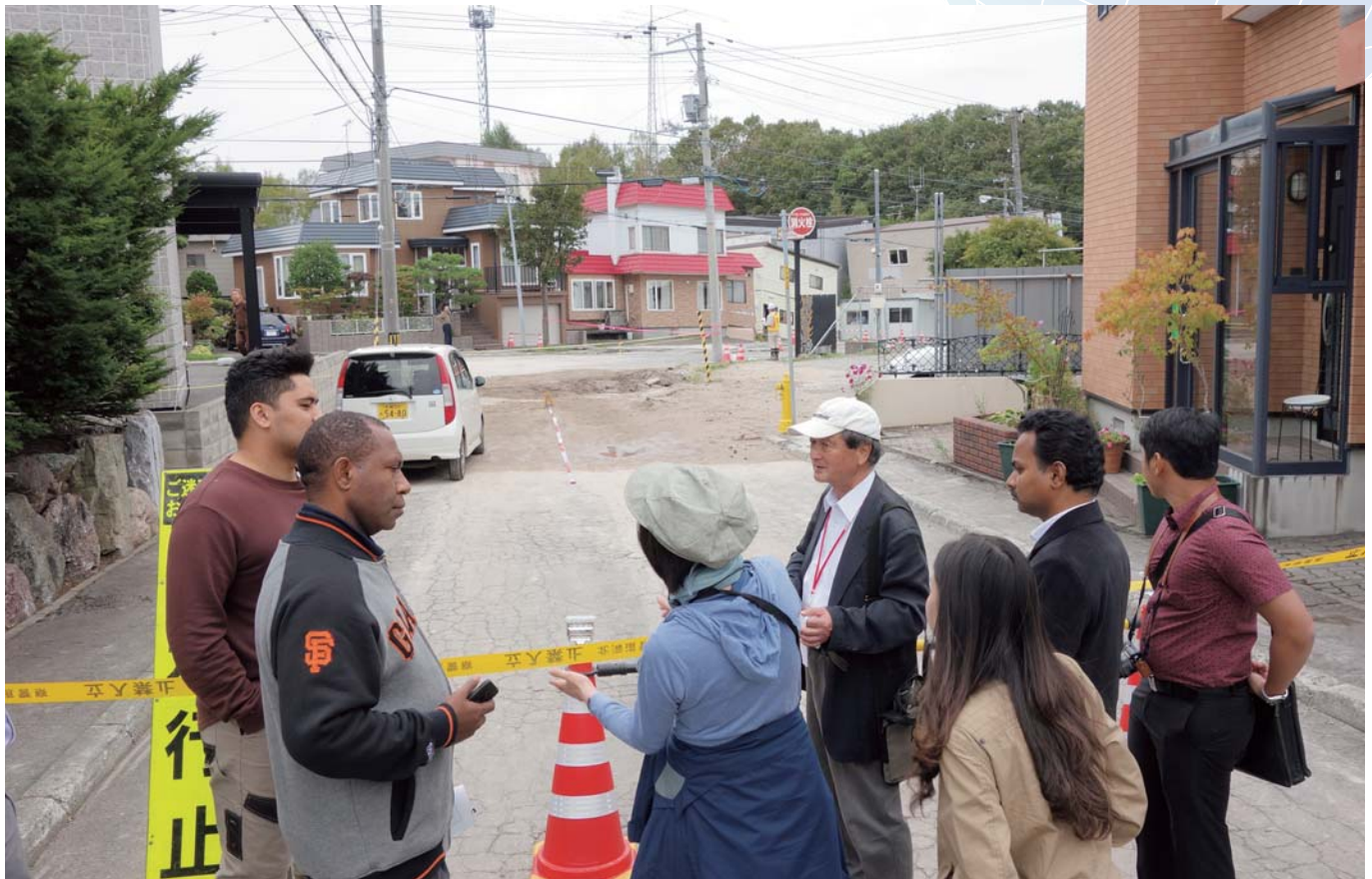
研修員の強い希望により、北海道胆振東部地震による被害を受けた道路を視察
