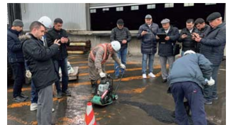
(上) アスファルト合材を使用した道路パッチング補修方法を学ぶ中央アジアの道路技術者
