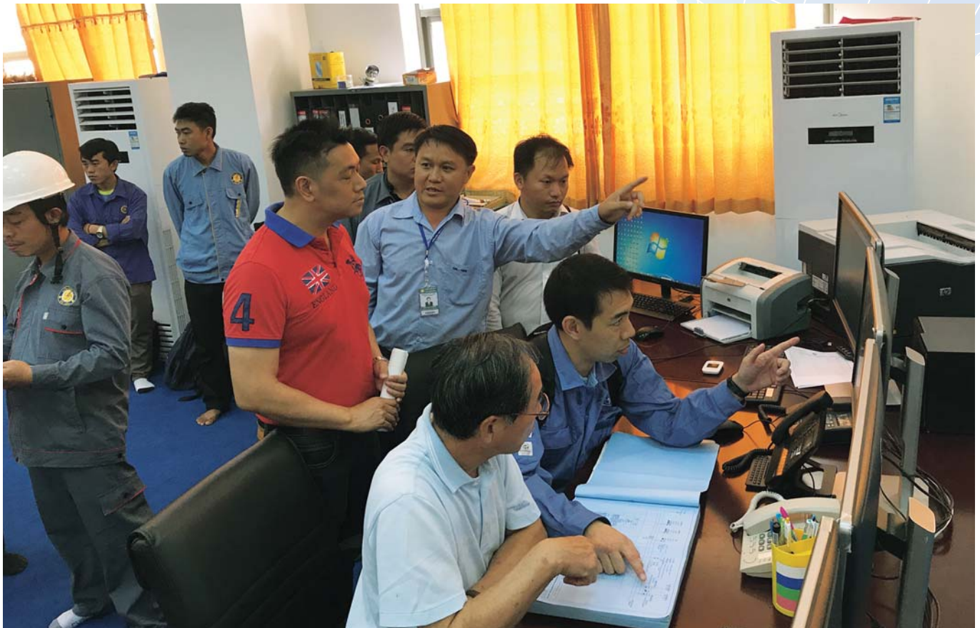
ナムカン発電所の既存の監視・制御システム調査
