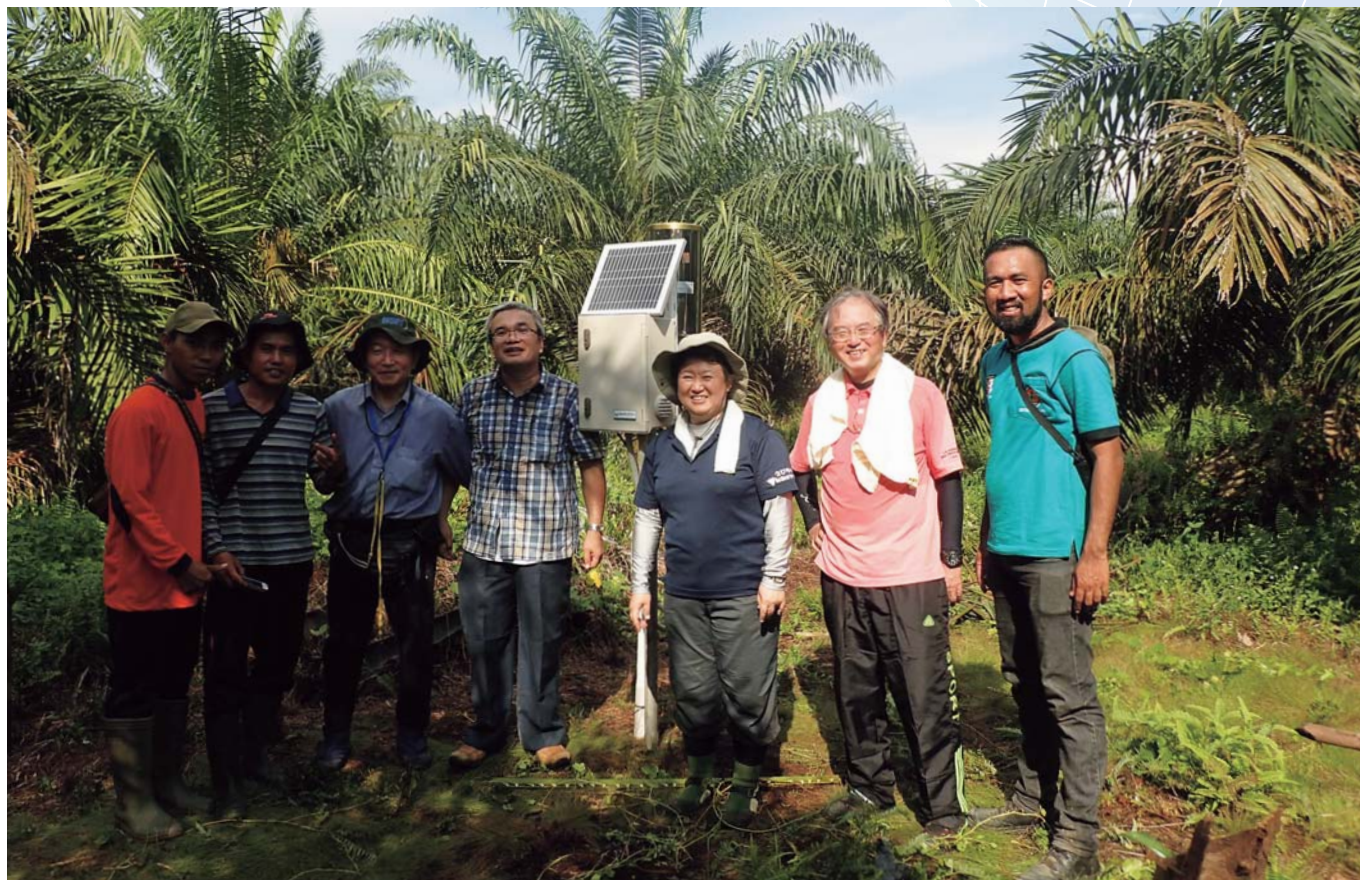
泥炭地に監視システムを設置
