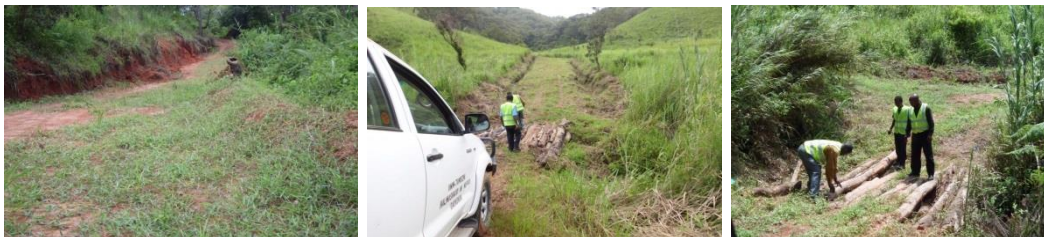
Shughuli za ujenzi zikiendelea
