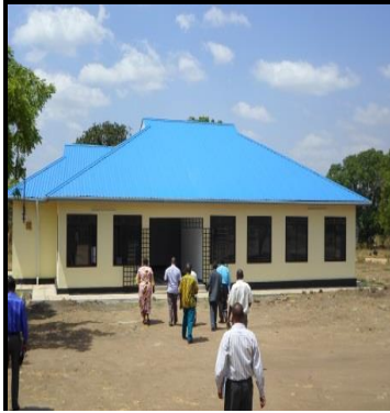
Jengo la Idara ya Ardhi
