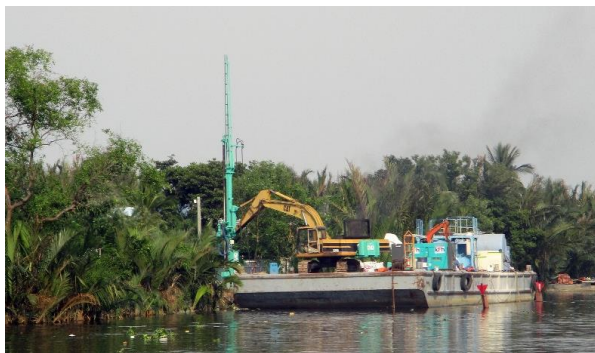
台船に乗せた機材で護岸工事を実施
