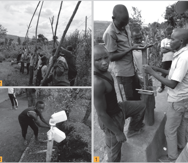
1 2 住民による井戸修理の様子。ンゴマ郡ではアフリディブという種類の手押しポンプが付いた深井戸が一般的だった。2は給水立上り管を取り出す作業 3 井垣さんが支援した中・高等学校の衛生クラブが設置した簡易手洗い設備
