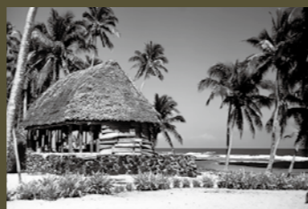
伝統的なサモアの家「サモアンファレ」。 柱以外の壁がない=1980年
