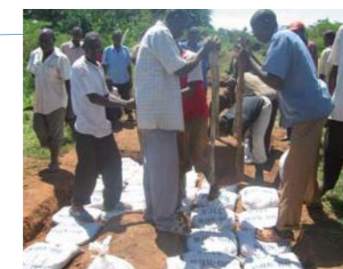
土のうを使って道を整備。ノウハウは現職の木村理事長から直伝されたもの。
