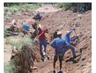
炎天下の下、老朽化した排水管の入れ替え作業。
