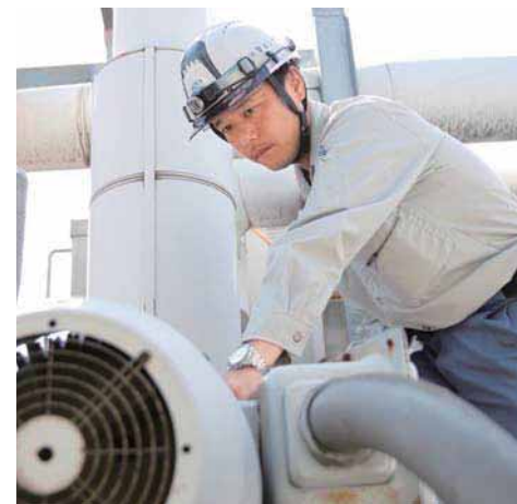
機器の状態を確認し、作業方法を検討する。
