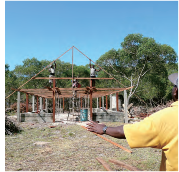
自然公園ビジターセンター建設
