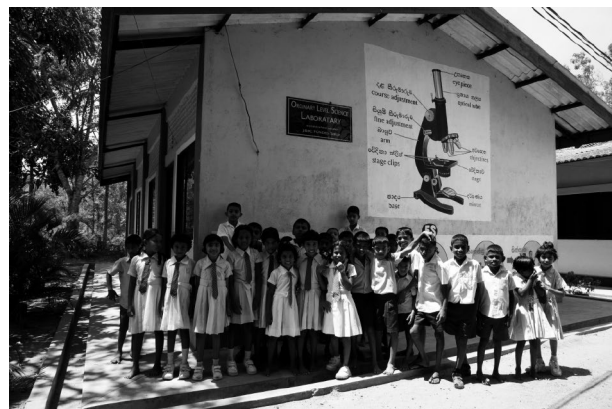
平和構築支援のための円借款（2004年）により建設されたスリランカの学校
