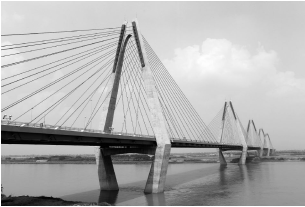
STEP制度を活用して建設されたベトナムのニャッタン橋が完成 2015年
