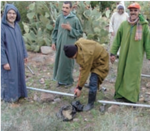
地方給水:建設された井戸の維持管理を行う住民たち
