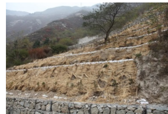
土留工に伏せ工を組み合わせた後に植栽
