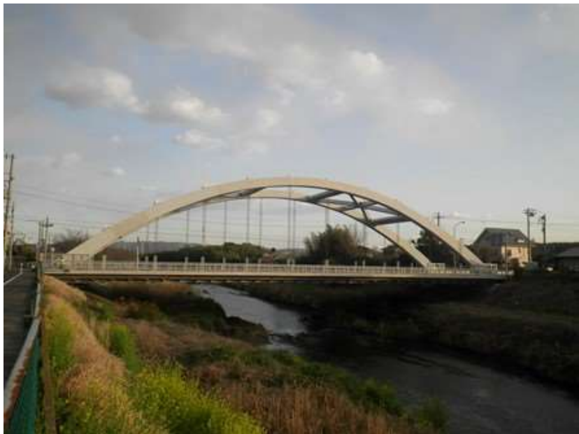
2級河川(小糸川)の架設橋梁
