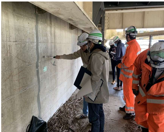
実橋梁点検中の様子
