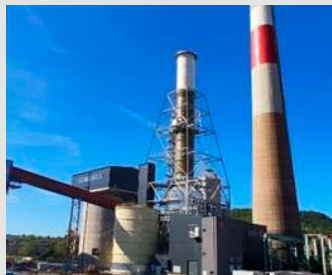
Projekat izgradnje odsumporavanja dimnih gasova za termoelektranu Ugljevik
