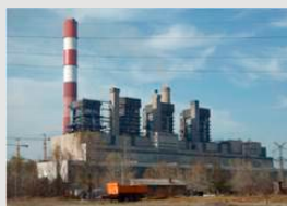
Projekat izgradnje postrojenja odsumporavanja dimnih gasova za termoelektranu Nikola Tesla
