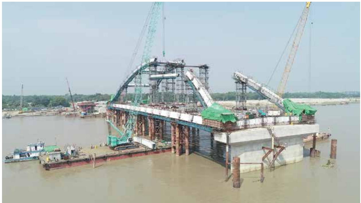
建設中のカルナ橋 (写真: 鉄建建設・アブドルモネム・横川ブリッジ建設企業体)
