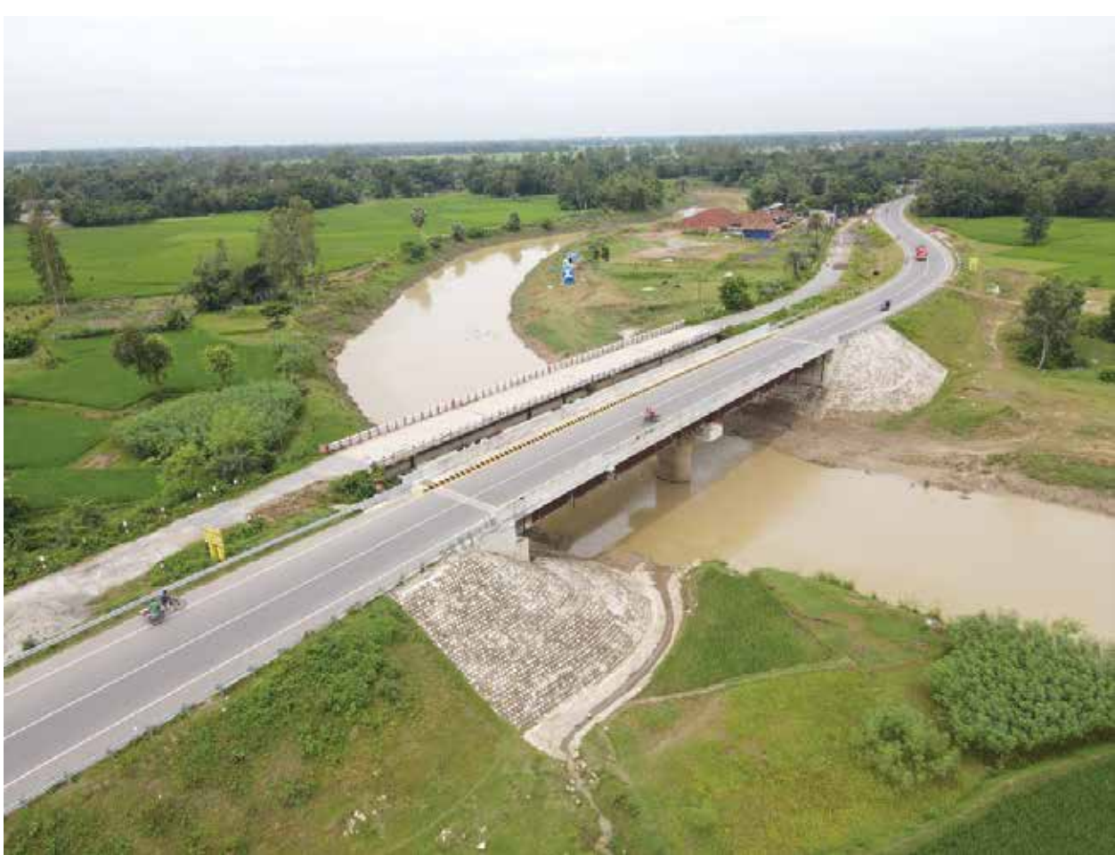
連結性強化関連で建設した橋 (写真: PW-02コントラクター)
