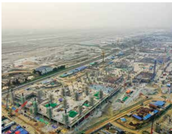
建設中の国際線第三旅客ターミナル (写真: JICA)
