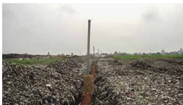
現在の処分場(ガス処理・覆土を行う衛生埋立て) (写真: 八千代エンジニアリング株式会社)
