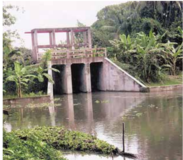
小規模水資源開発事業によって建設された水門 (写真: JICA)
