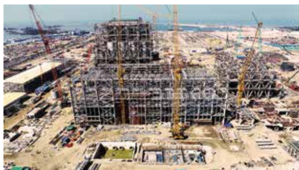
建設中のプロジェクトサイト (写真: JICA)
