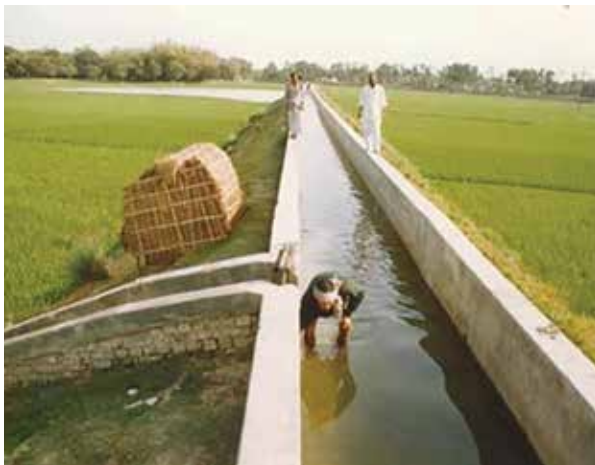
小規模水資源開発事業によって整備された水路 (写真: JICA)
