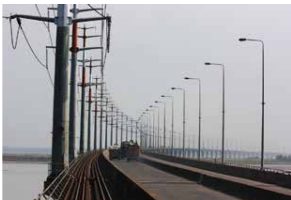
バングラデシュ国民悲願の「ジャムナ多目的橋」。一日に約11,000台の車両が通過するほか、列車の線路もある。送電線とガスパイプも併設されており、バングラデシュ東西をつなぐ大動脈となっている。(写真: Masud Al Mamun)
