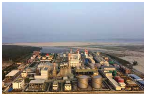
シラジガンジ高効率ガス火力発電事業 (写真: JICA)
