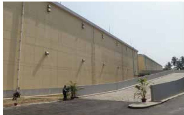
食糧倉庫2階にアクセスする斜路 (写真: JICA)
