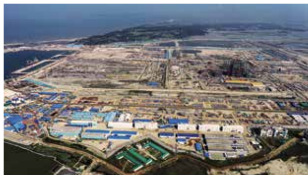
マタバリ超々臨界石炭火力発電所 建設状況 (写真: JICA(MJVC))
