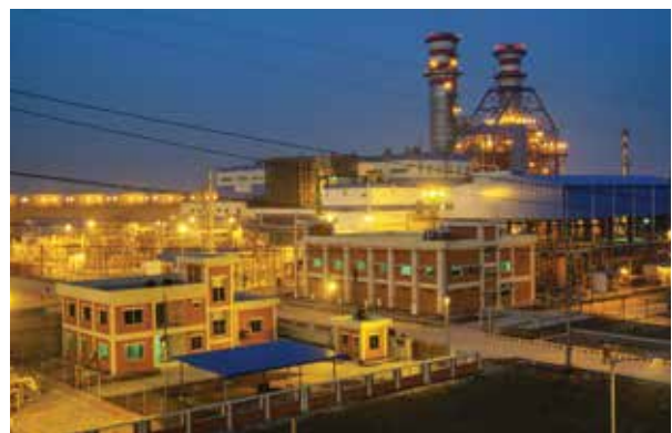
ベラマラ・コンバインドサイクル火力発電所(写真: JICA)
