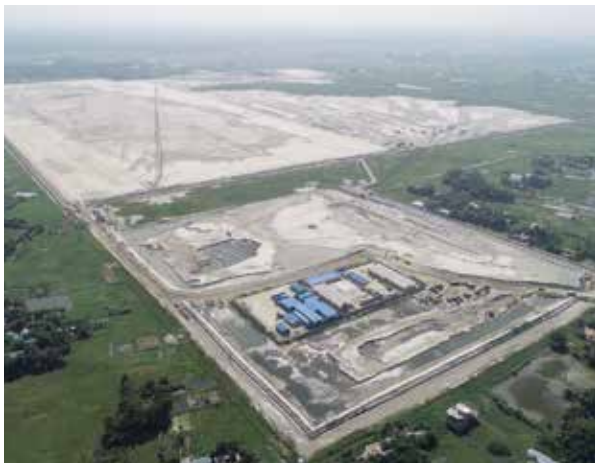
盛土の様子 (写真: 住友商事株式会社)
