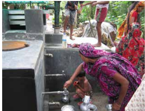
砒素汚染が広がるゴドカリ村に設置された代替水源 (写真: アジア砒素ネットワーク)
