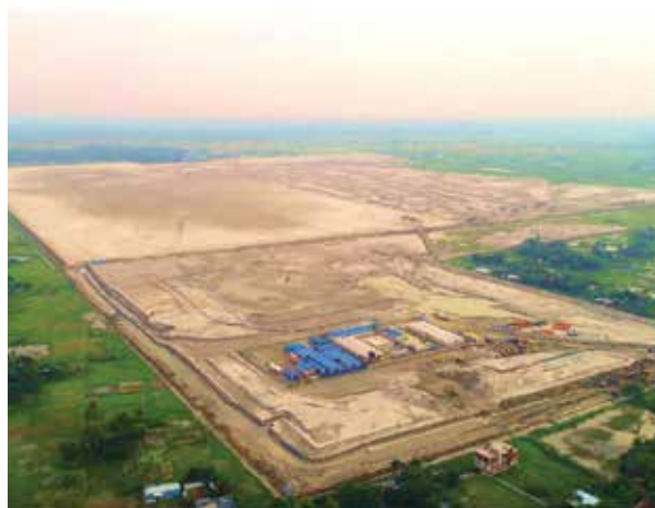
建設中のプロジェクトサイト(写真: JICA)
