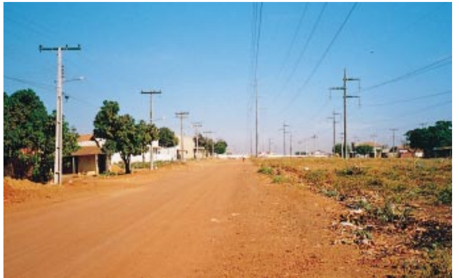
建設された送電線
