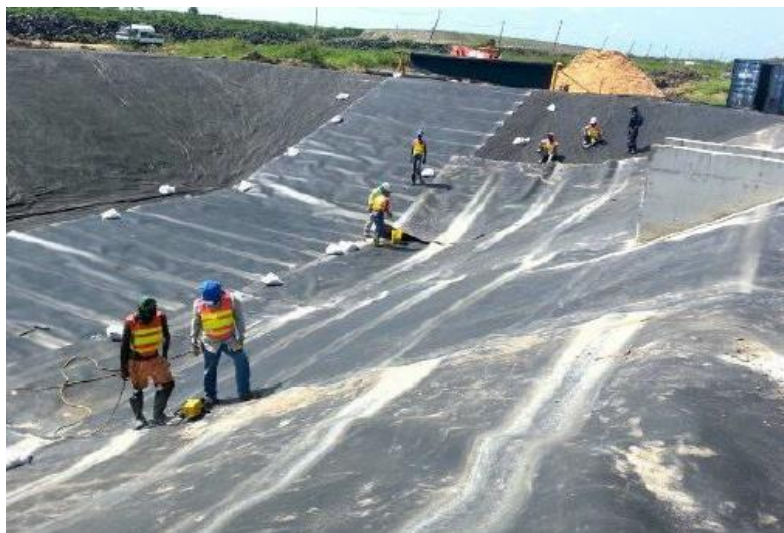
浸出水処理池の法面工事
