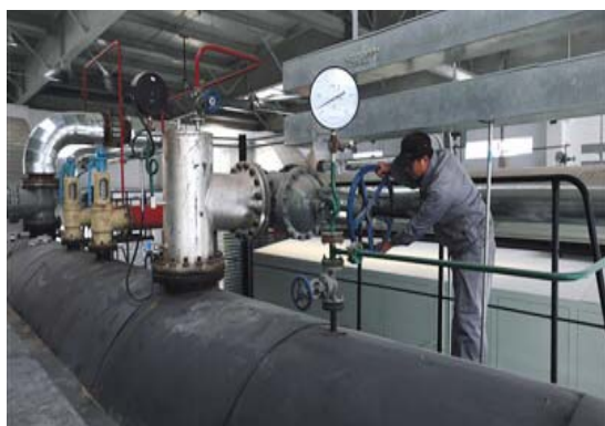
熱供給配管の点検 (実施機関より提供)
