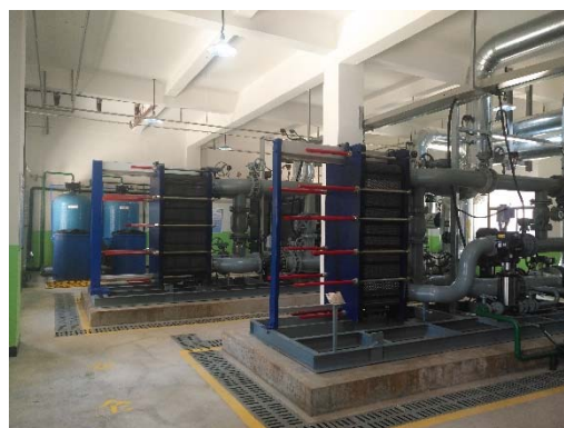
熱交換設備 (事後評価専門家より提供)
