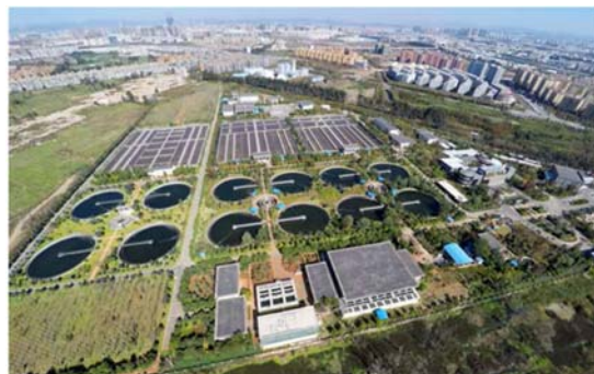
第 7 汚水処理場
