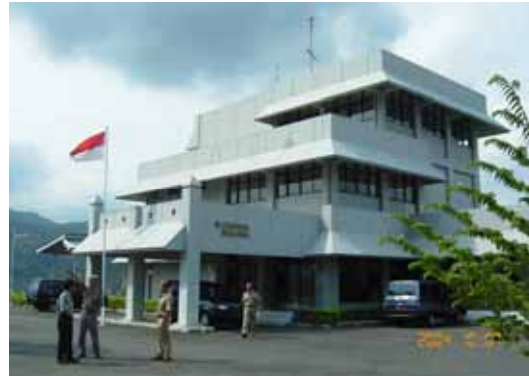
Wonorejo Dam Admin Bldg.
