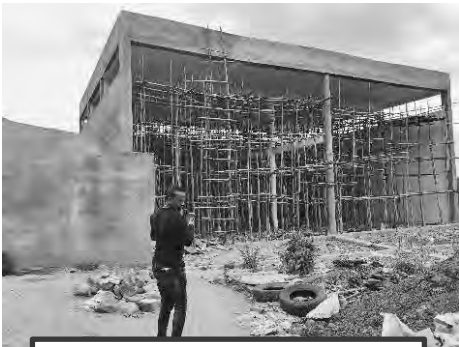
2-3 中間集積場新規建設
