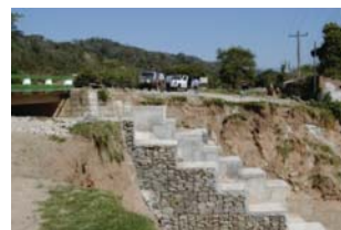
Reforzamiento del terraplén de la Ruta Nacional 7 en Bolivia
