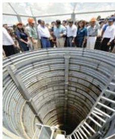
Pozo de captación en la región de El Berrinche (Acto de final de obra)
