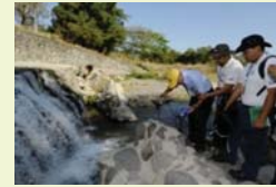
Técnicos de DACGER y especialistas de Japón miden la profundidad del río durante la inspección del puente dañado.
