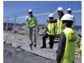
Estudio de los daños en el puerto de Talcahuano
