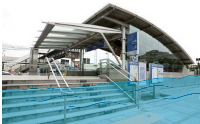
Metro resistente a las inundaciones (Tailandia) (Fotografía: Shinichi Kuno/JICA)
