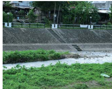
Los escalones integrados en la protección de la orilla del río se utilizan para evaluar visualmente el nivel del agua durante una inundación. (Fotografía: JICA)
