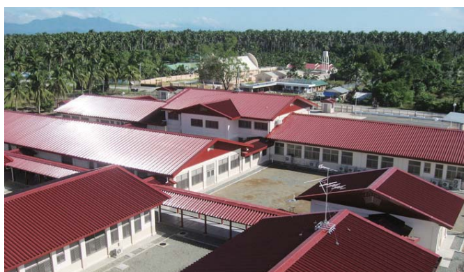
Hospital resistente a los tifones (Filipinas) (Fotografía: JICA)
