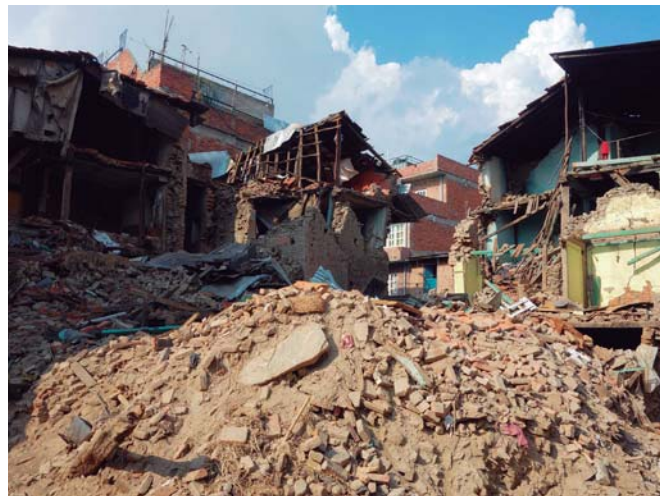
Daños causados por el terremoto de 2015 en Nepal (Fotografía: JICA)
