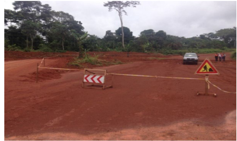
写真5 工事中迂回路標識
