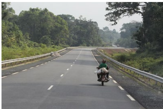
写真3 完成した道路
