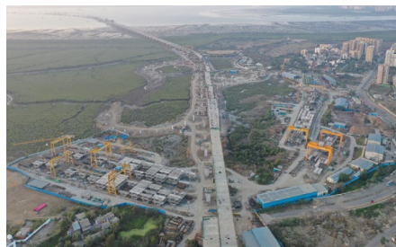
プレキャストセグメント橋 製作ヤード
