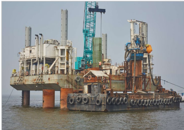
制振機能付き掘削機 (Reverse Circulation Drilling: RCD)
