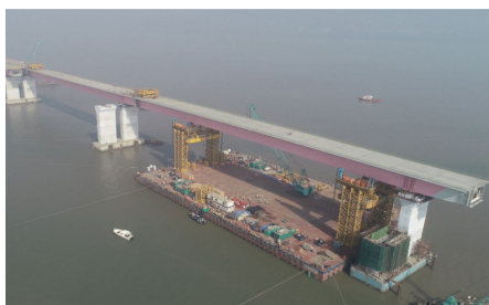
インド最大の鋼床版 (スパン長180m、重量2565MT)
