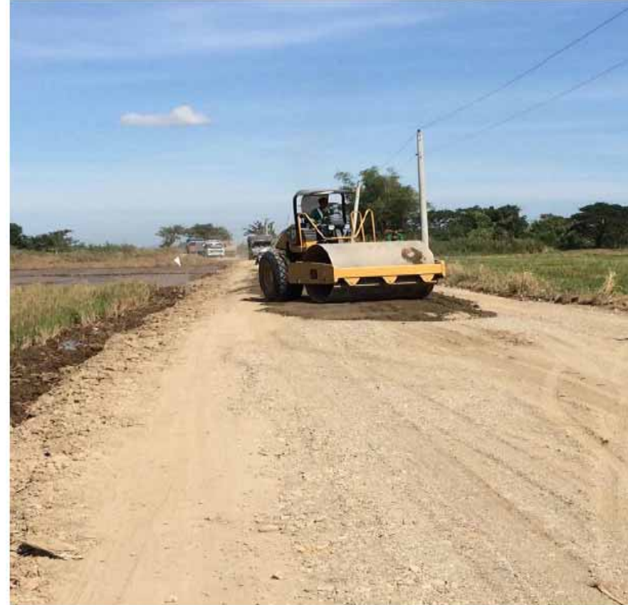
写真 CP 4 散水作業中の写真
