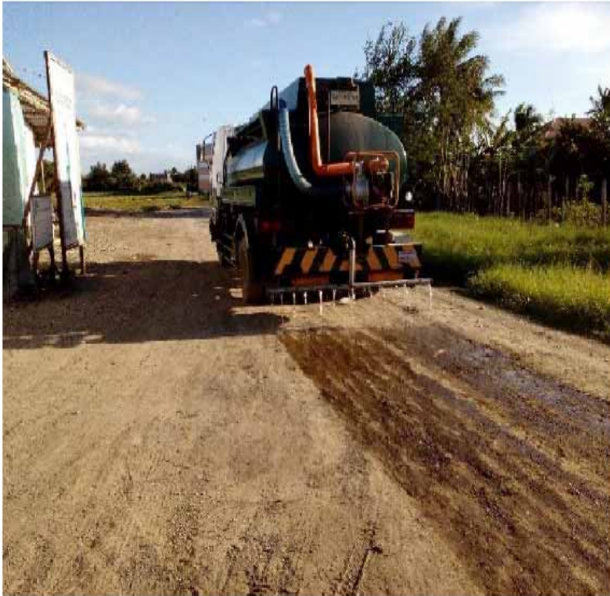
写真 CP 3 散水作業中の写真
