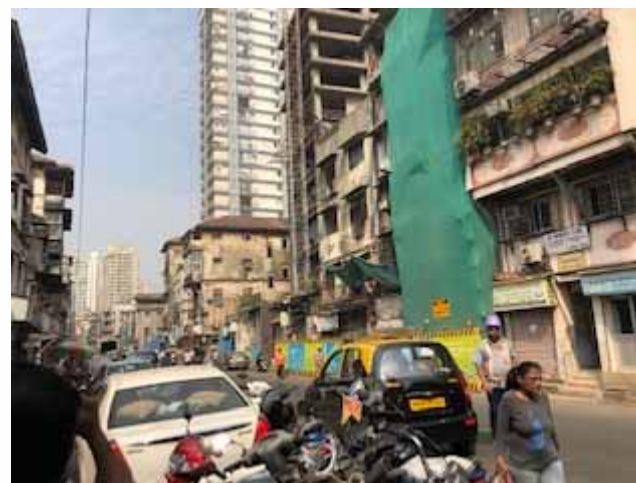
写真③: 第二工区建設工事現場 (2018年12月)
