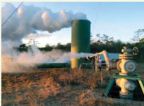
Test de puits géothermiques
