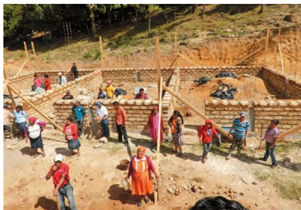
Un projet de construction d'un bâtiment scolaire utilisant des ressources locales. Chacun des 13 groupes communautaires travaillent tous les jours à tour de rôle. Les membres du personnel de l'association municipale au Honduras fournissent des conseils afin que les normes du ministère de l'Éducation soient respectées (Honduras : projet de renforcement des capacités des gouvernements locaux pour le développement régional).
