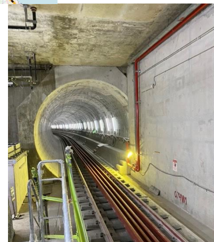
↑ 建設中のホーチミン都市鉄道1号線
