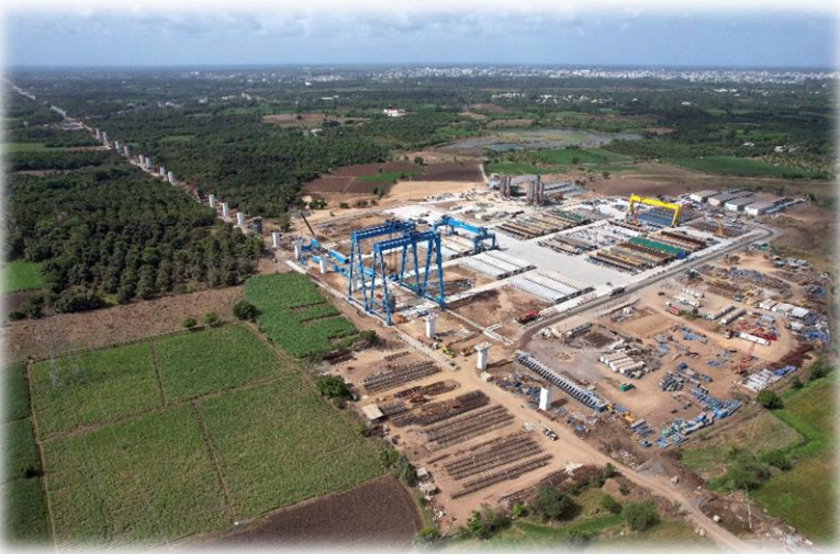
インド高速鉄道高架橋
