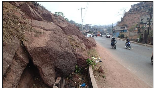
写真1 Villa Nueva 地区道路沿いで 2018年11月に発生した斜面崩壊/落石
