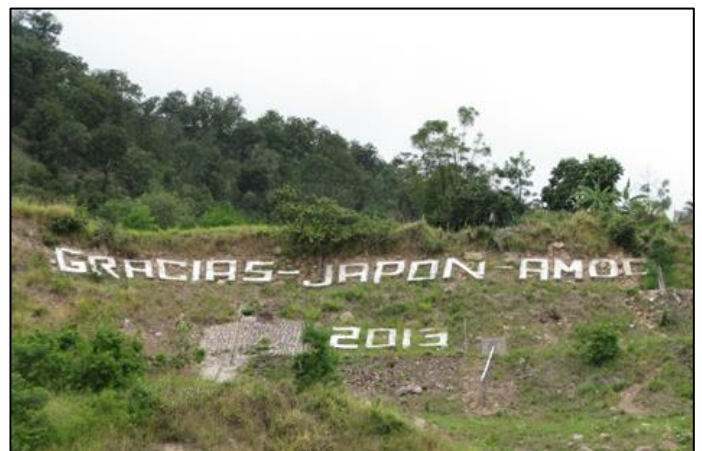
写真2 無償資金協力により斜面災害対策工事を実施
