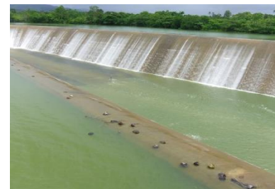
ボホール灌漑事業で整備したマリナオダム
