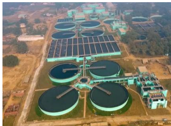
ガンジス川流域の下水処理施設
