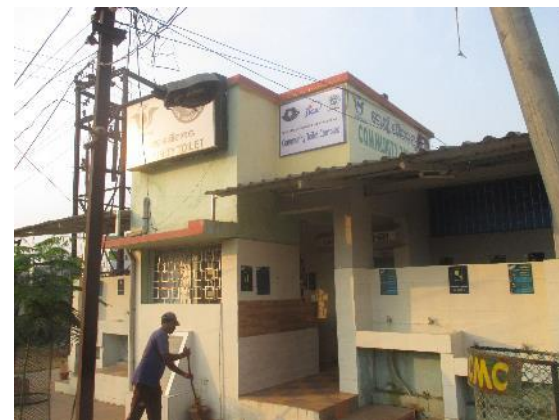
JICAが設置した共同トイレ
