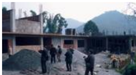
建設中の母子保健病院を視察する駒ヶ根市民訪問団
