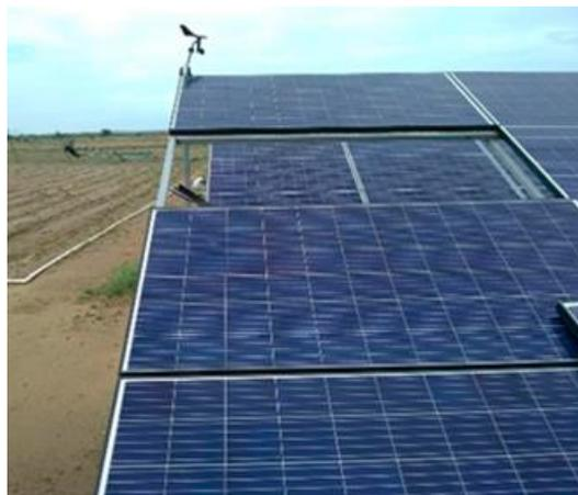
**Fotografía 5.** Daño de panel fotovoltaico debido por un huracán.
