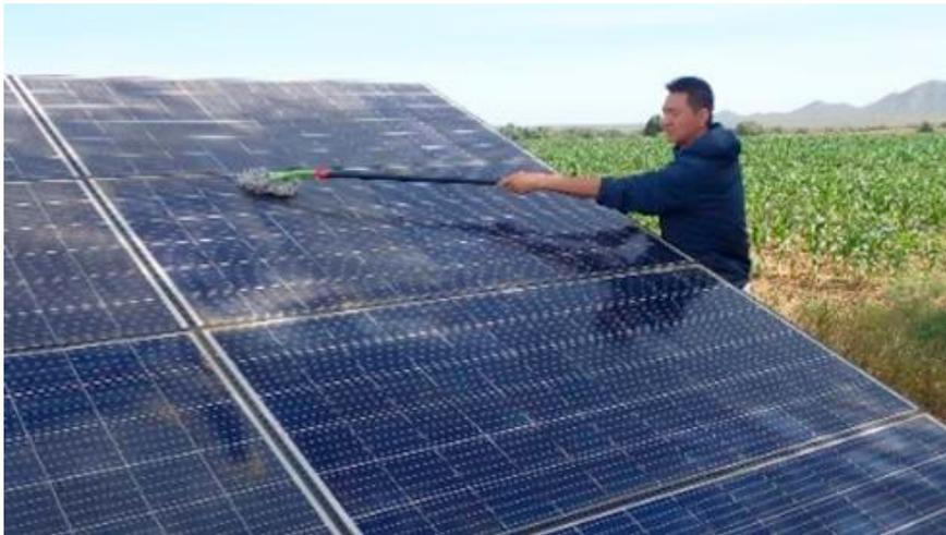
**Fotografía 1.** Limpieza de panel fotovoltaico.
