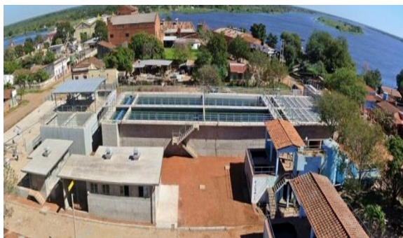
コンセプション市浄水場（コンセプション県）
