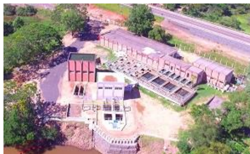
テビクアルミ浄水場 取水施設
