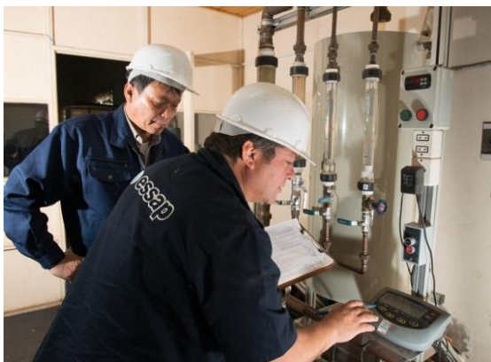
水道メーターの点検
