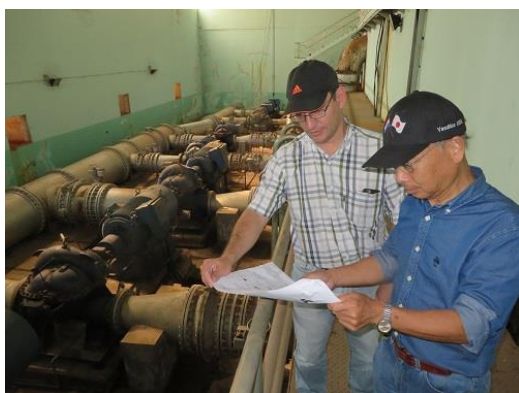
専門家による配水網確認
