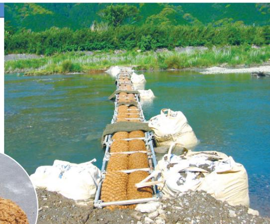
河川の濁水対策として設置されたバイオログフィルターは日本国内でも活用されている（三重県の船津川／写真上）天然ヤシ繊維素材の「バイオログフィルター」（写真左）
