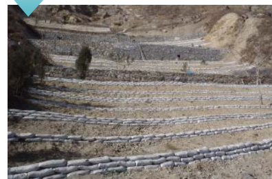
技プロによる治山工事の実施
